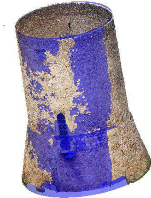
Figura 8. Anàlisi formal de la Torre a partir de formes primitives.
