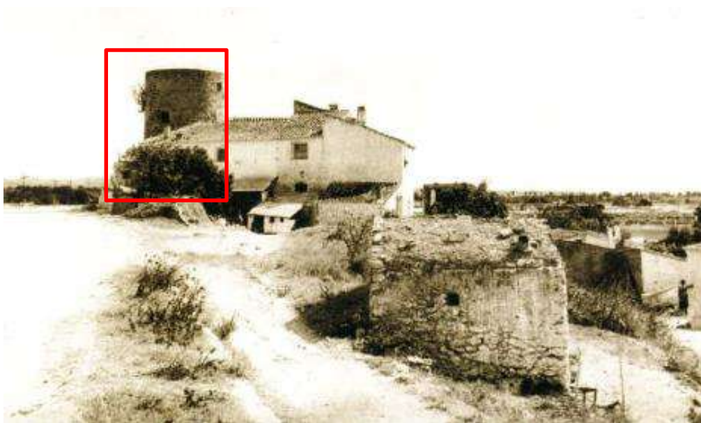
Figura 1. Fotografia estat de la Torre amb les edificacions adjacents 2
