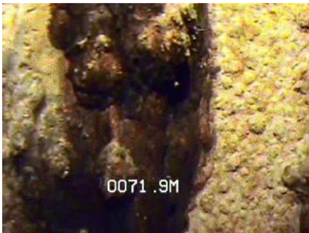
Figura 11. Visió lateral. Detall d'incrustació de color marró vermellós.
